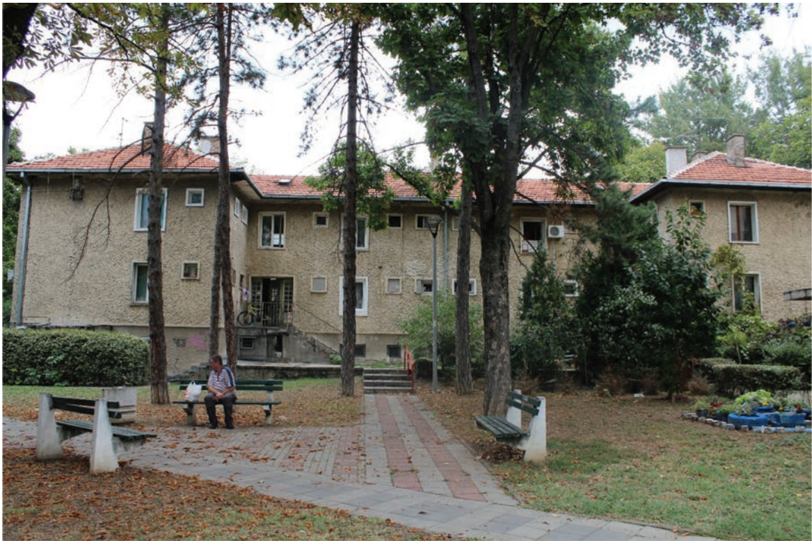
Сл. 5 Монтажна зграда код Цветкове пијаце, тип Рајко Татић, данашњи изглед (Извор: фотографија аутора) / Fig. 5 Present-day appearance of prefabricated building near Cvetsko's Green Market, type Rajko Tatić (Source: photo by author)
