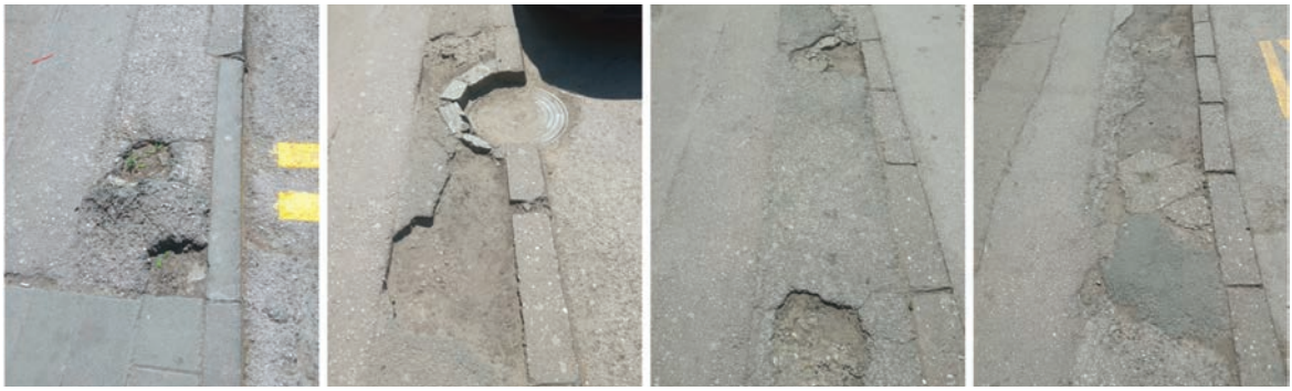
Сл. 5. Стање коловоза на Трифковићевом тргу (Извор: Вук Гарача, 2025.) / Fig. 5 Condition of the street road at Trifković Square (Source: Vuk Garača, 2025)
