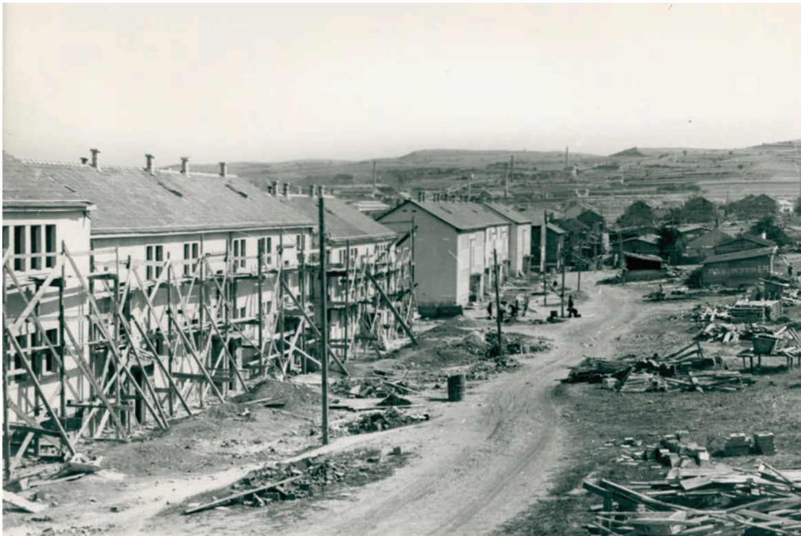
Сл. 6 Стамбена колонија на Карабурми у изградњи, тип Јован Бјеловић, око 1950. (Извор: МГБ, Ур_5863) / Fig. 6 Residential neighborhood at Karaburma during construction, type Jovan Bjelović, around 1950 (Source: Belgrade City Museum, Ur_5863)
