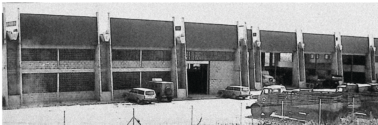
Sl. 260 „Servis fabrike Volvo” Tipičan primer postkolonijalne arhitekture: Uvozna tehnologija, konstruktivni sistem i strani projektant, uz maksimalno poštovanje principa izgradnje u ovom klimatskom području, proverenih u tradicionalnoj arhitekturi, sa primenjenim elementima iz kolonijalnog perioda (izgrađeno 1980. godine)
