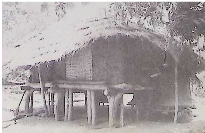
Sl. 93 Primer izgrađenog objekta na drvenim stubovima čiji je pod znatno odignut od tla. Pripada etničkoj grupi „Beafada” koje nastanjuje južni priobalni pojas sa obilnim padavinama. Objekat služi za čuvanje žitarica i drugih namirnica. Prema našoj sistematizaciji, nosio bi šifru: 1.7.2.1.2.1.
