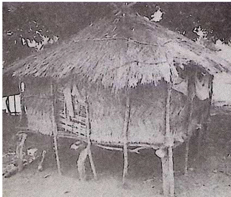
Sl. 155 Objekat za čuvanje žitarica etničke grupacije „Beafada” regiona Kinjara, karakteriše dobra provetrenost i zaštita od vode, bilo da je ona atmosferska ili površinska. Zidovi su od „krintina”, a osnovni konstruktivni sistem je drveni skelet. Bolju zaštitu obezbeđuje i krošnja velikog mango-drвета ispod koga je objekat izgrađen.
