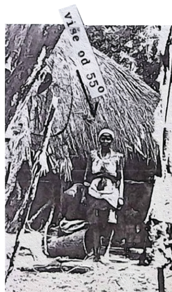
Sl. 117 Naseobina na rečnom ostrvu „Ponta Cabral” koja pripada etničkoj grupi „Mandjako”, gradi svoja staništa sa vrlo strmim krovovima zbog obilnih atmosferskih padavina.
