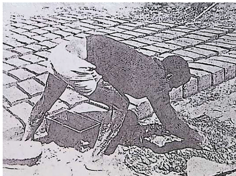
Sl. 104 Izrada blokova od zemljanog naboja koji se meša sa pirinčanom slamom prethodno sitno iseckanom, ili plevom. Posle sušenja na vazduhu blokovi su spremni za zidanje. Snimak je iz mesta Njakra, (Nhacra), dvadesetak km severno od glavnog grada.
