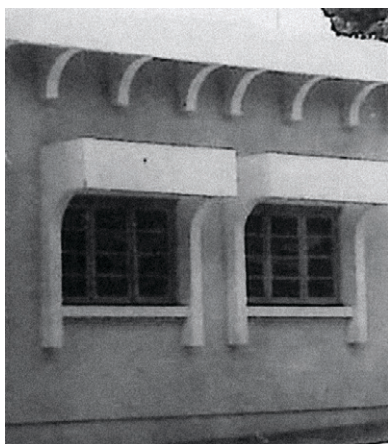
Sl. 34, 35, 36 i 37 Vrste zaštite prozorskih otvora betonskim elementima
