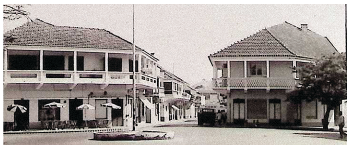
Sl. 215 Ugaoni položaj je najatraktivniji za objekte ove vrste što je očigledno i sa priložene fotografije.
