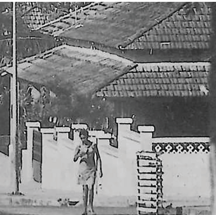
Sl. 31 Krovovi i nadstrešnice
