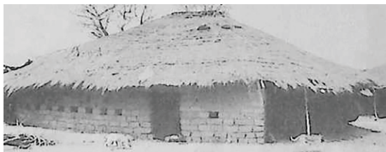
Sl. 109 Kuća etničke grupe „Balanta” sa zidovima zidanim blokovima od zemljanog naboja. Objekti zidani na ovaj način, najčešće su pravougaonog oblika.
