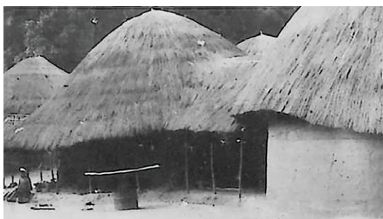
Sl. 108 Primer kuće sa masivnim zidovima od zemljanog naboja. Etnička grupa „Papel”.
