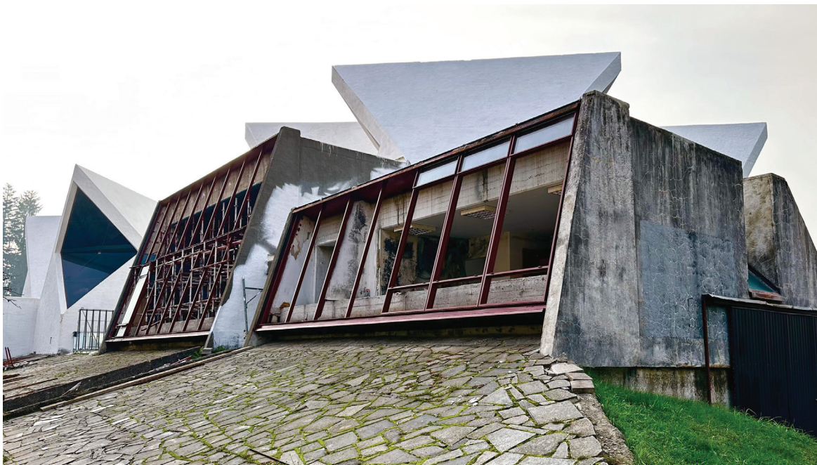
Сл. 9. Радови на реконструкцији Спомен-дома у Колашину, 2024, фотографија: Викторија Николић (извор: приватна архива). / Fig. 9. Reconstruction works on Memorial house in Kolašin, 2024, photo: Viktorija Nikolić (source: private archive). /
