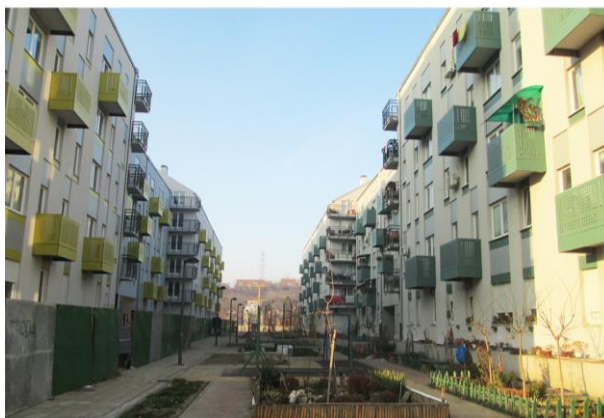
Slika 6. Objekti socijalnog stanovanja – C3 (desno) i novoizgrađeni objekat C2 (levo), fotografija iz 2016. godine Izvor: fotodokumentacija autora
